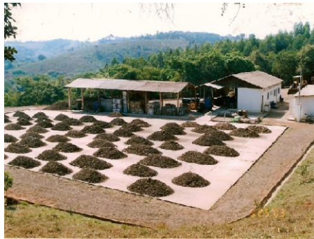
Figura 5: Vista Geral da UTCL
